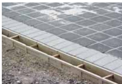
Baan in aanleg met tijdelijke afstandhouders als plaatsingshulp
