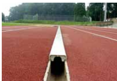
Opliggend kunststof deksel voor de Sportgoot NW125
