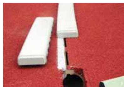
Overgang van open goot naar sleufgoot
