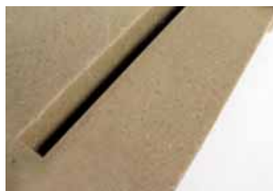
Sleuf voor doorgaande aansluiting toplaag
