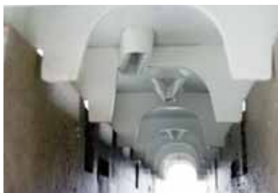
Versterkingsribben voorkomen het verschuiven van de afdekking
