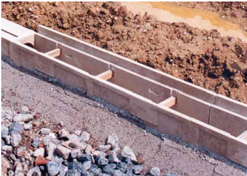
Sportgoot NW125 met verhoogde rand en tijdelijke inbouwhulp klossen
