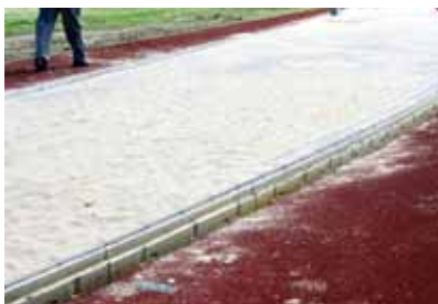
Baan in aanleg
