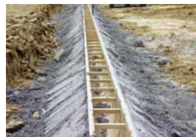
Baan in aanleg met ommanteling betonkwaliteit C 12/15.
